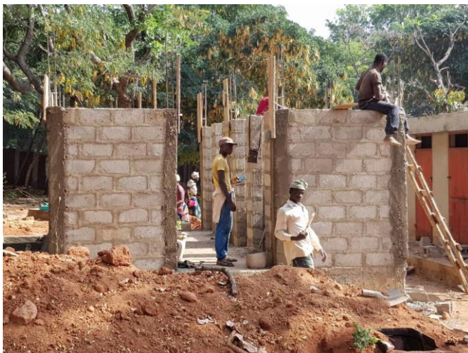
Hier entstehen die Duschen und Latrinen für die Maternité.
